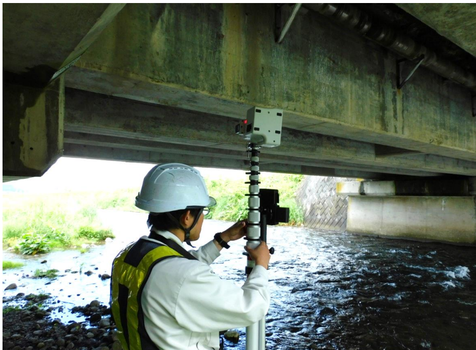
図1 橋梁点検ロボットカメラによる点検状況
