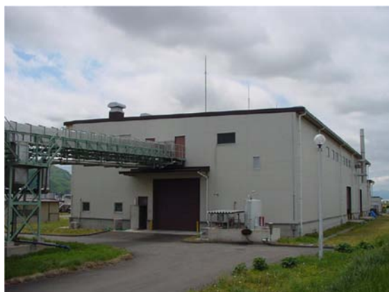
中野浄化管理センター汚泥堆肥化施設
