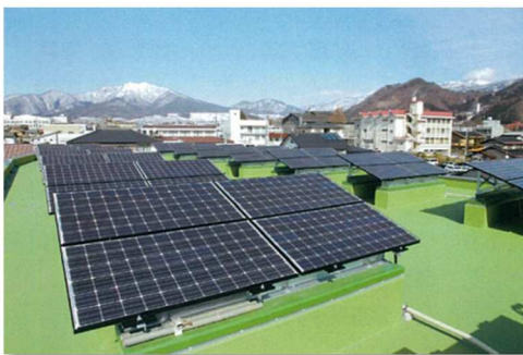
再生可能エネルギーを導入した公共施設(ひまわり保育園)
